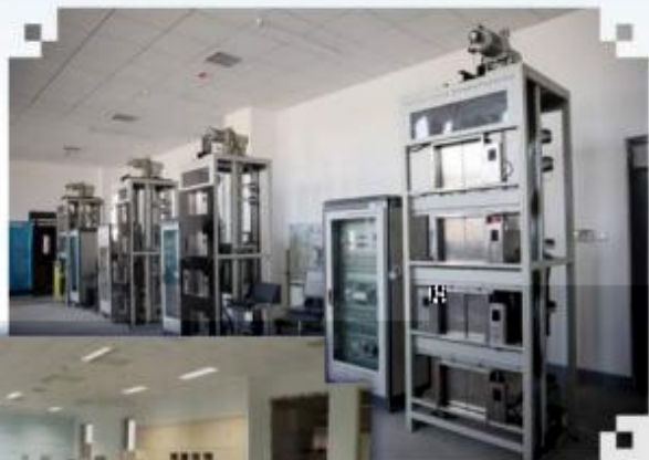
智能电梯安装调试 维护训练场所
